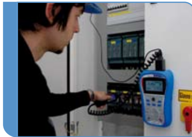
Prüfen der Impedanz an der Schaltschränken.
