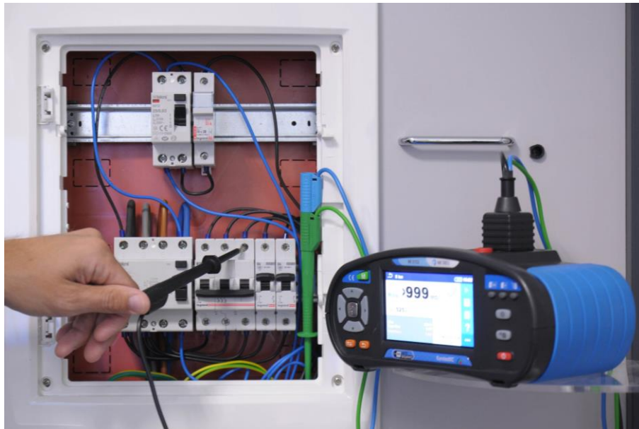
Abbildung 2-34: Isolationswiderstandsmessung am Verteiler - ausschalten der Stromkreise während der Messung
